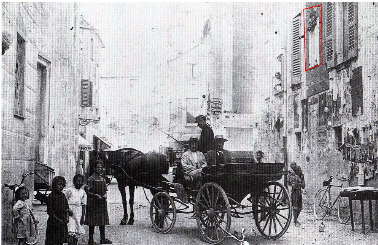
Facciata del vecchio Municipio di fronte alla Chiesa Parrocchiale. Fra le due finestre, cerchiata in rosso, la lapide dedicata al Cap. Francesco Demaestri. Nel 1962 il Municipio fu trasferito ma solo nel 1974 la lapide verrà posizionata sulla facciata ovest del nuovo edificio (Villa Albini)
